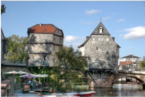
31/42km: Brückenhäuser in Bad Kreuznach
