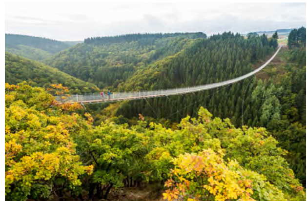
Hängeseilbrücke „Geierlay“ Mörsdorf
