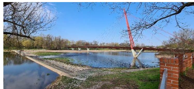
Fußgängerbrücke am Cracauer Wasserfall
